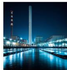
6. Водоснабжение и водоотведение
